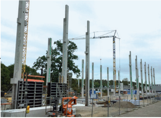
19. September 2019: Fertigstellung der Säulen
