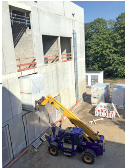
21. Juli 2020: Anlieferung der Klimageräte
