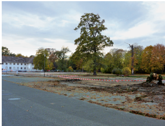
23. Oktober 2018: Das Baugrundstück ist vorbereitet
