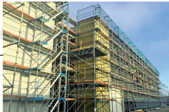
26. November 2020: Vorbereitung der Fassade
